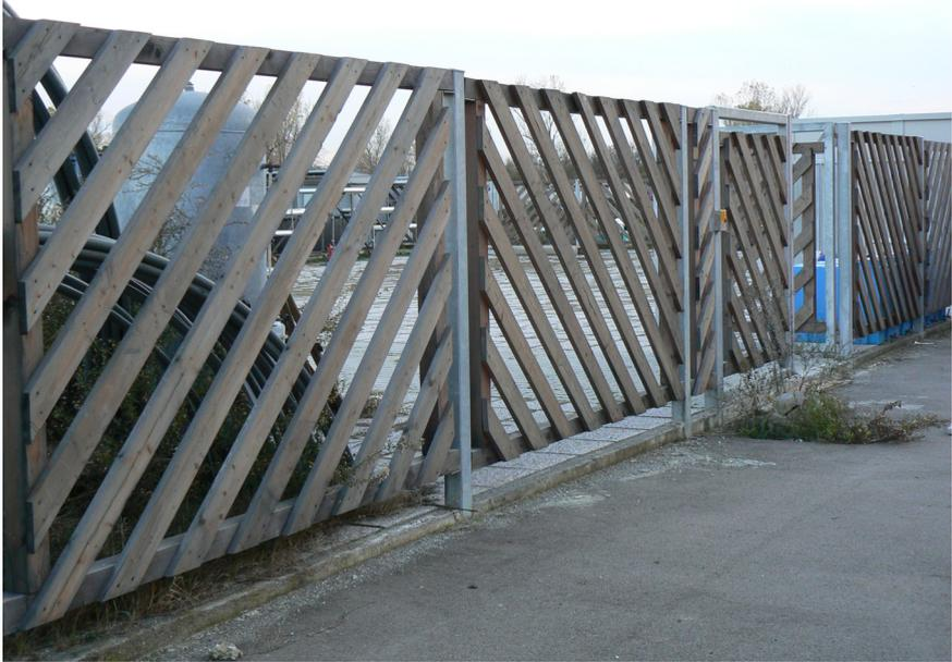
*Figura 4.15: Il larice tende a diventare grigio col tempo ma in maniera non uniforme; questa recinzione è stata trattata con impregnante grigio che, oltre a conferire al materiale una elevata protezione dalla luce solare, ne uniforma il colore e conferisce fin dall'inizio il colore che assumerebbe nel tempo.*
