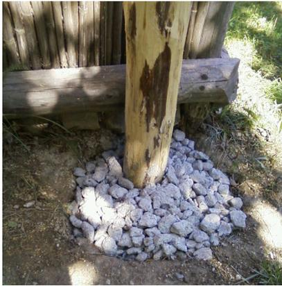
Figura 4.3: Anche se non è mai una buona soluzione prolungare un palo sotto terra, in questo caso il bicchiere è stato realizzato con calcestruzzo fortemente drenante, ovvero povero di inerte fino. Alla base del getto è presente un tubo di drenaggio. In tal modo si favorisce la ventilazione del legno anche al disotto del piano campagna e si evita il ristagno di umidità.
