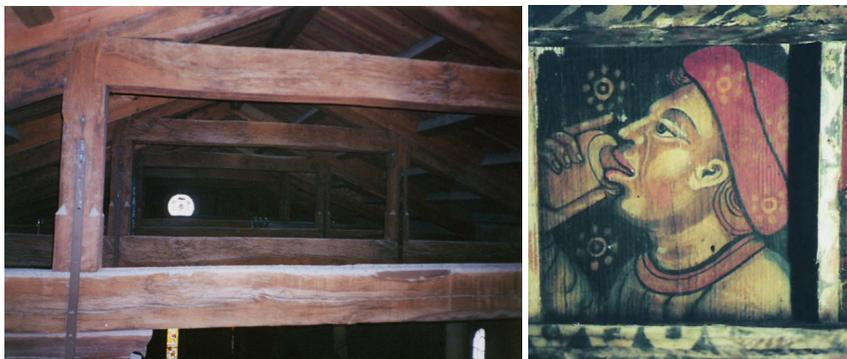
Figura 5.1: Le strutture lignee storiche caratteristiche in Italia sono soprattutto costituite da coperture e solai con elementi semplici o complessi, come le capriate (foto a sinistra: Cattedrale di Cesena) che molto spesso costituiscono supporto a opere d'arte di valore unico (foto a destra: Cattedrale di Nicosia).
