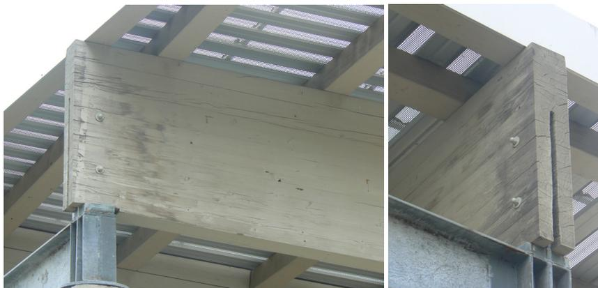
Figura 4.13: In questo caso la testa è addirittura in parte esposta alle intemperie, in queste condizioni il problema non è solo estetico ma in pochi anni la struttura potrebbe subire degrado da funghi della carie.
