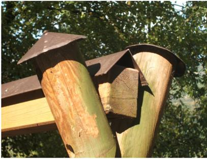
Figura 4.7: Protezione delle sezioni di testa e dell'estradosso; questi particolari costruttivi semplici ma efficaci conferiscono molti anni di durabilità alle strutture esposte altrimenti destinate a rapido degrado in pochi anni.
