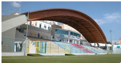
Figura 1.2: La copertura della tribuna dello stadio di Manfredonia (FG), archi di legno lamellare incollato di 80m di luce libera.
