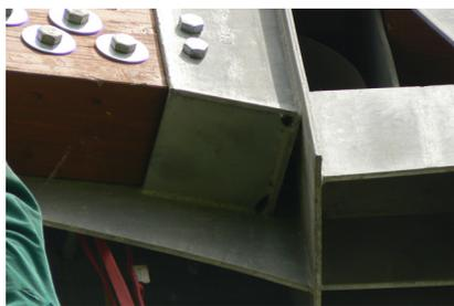
Figura 4.5: I fori di drenaggio alla base delle scarpe metalliche assicurano la ventilazione e il deflusso delle acque. Devono essere sufficientemente ampi da non potersi ostruire.
