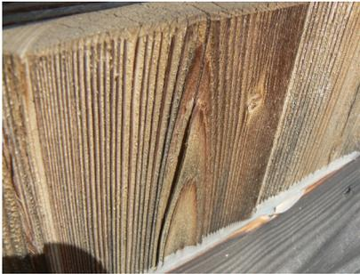
Figura 3.12: Questo tavolato di larice esposto all'azione dei fattori atmosferici mostra un decadimento della superficie specialmente a carico della parte primaticcia (più tenera e porosa) degli anelli di accrescimento. Inoltre gli anelli più superficiali nella sezione tangenziale risultano parzialmente distaccati proprio a causa del degrado della parte primaticcia dell'anello.
