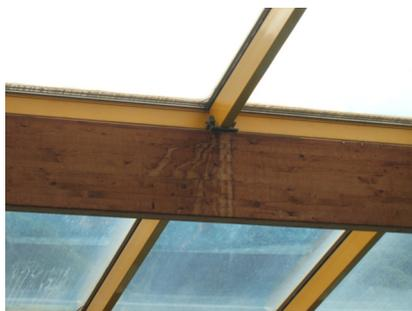
Figura 2.2: Anche in ambienti in cui l'umidità dell'aria è controllata e viene mantenuta al di sotto dell'85% (valore limite per il rischio di attacco fungino, vedere Figura 2.1), in corrispondenza dei ponti termici si può avere condensa che percola sul legno provocando dapprima semplici variazioni cromatiche in superficie e poi pericoloso attacco fungino. Questo fenomeno è particolarmente sentito nelle piscine.
