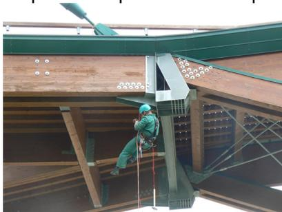
*Figura 5.3: Spesso la necessità di verificare elementi lignei o particolari costruttivi non raggiungibili neppure da ponteggi e bracci mobili, ha costretto ad utilizzare le tecniche di arrampicata o il "lavoro a corda"<sup>5</sup>.*
