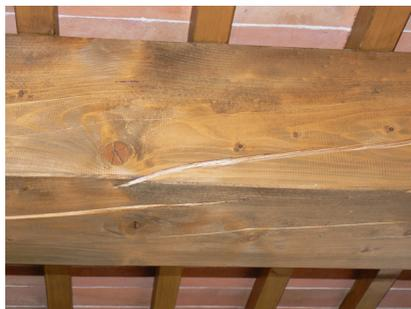
*Figura 1.11: Fessure che passano lo spigolo in una trave di legno massiccio e determinano un importante indebolimento della trave.*
