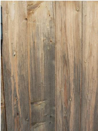
*Figura 4.16: Il tavolato di larice di rivestimento mostra maggiore ingrigimento nella parte bassa che nella parte alta più protetta dall'azione degli agenti atmosferici. L'impregnante protettivo risulta quasi completamente assente non essendo stato rinnovato negli anni.*
