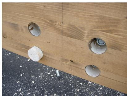
Figura 4.19: Le rondelle metalliche larghe favoriscono il ristagno e l'ingresso dell'acqua piovana nel giunto, è buona norma incassare la testa dei bulloni e chiudere con tappo di legno incollato.
