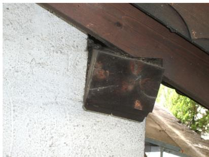
Figura 3.11: A causa della stagionatura in opera la trave di banchina messa in opera umida ha ruotato nel tempo. Il travicello non ha più l'appoggio in piano e tenderebbe a scivolare se non ci fosse un efficace unione meccanica (vite o chiodo non visibile nella foto). Anche se il problema strutturale è risolto attraverso l'unione meccanica, resta comunque il problema estetico.
