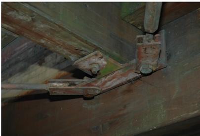
Figura 3.14: Ossidazione di elementi metallici verniciati ai quali non è stata rinnovata la verniciatura nel tempo. In queste condizioni è necessaria la zincatura
