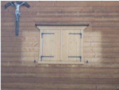
Figura 3.13: L'azione della luce solare ha provocato ingrigimento del legno maggiormente esposto; ai lati della finestra si notano invece zone meno ossidate in quanto protette dalla luce solare dalle persiane aperte.
